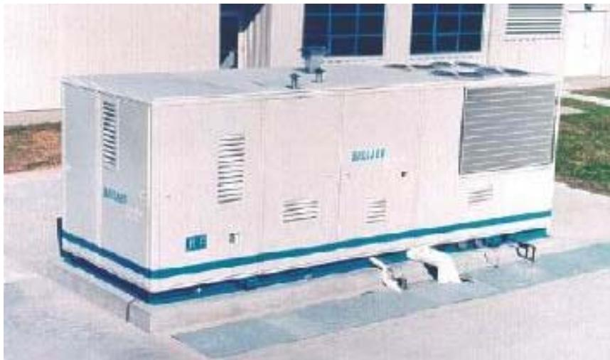
Figura 2.41 – Generatore elettrico *Ballard* da 250 kW alimentato a gas naturale
